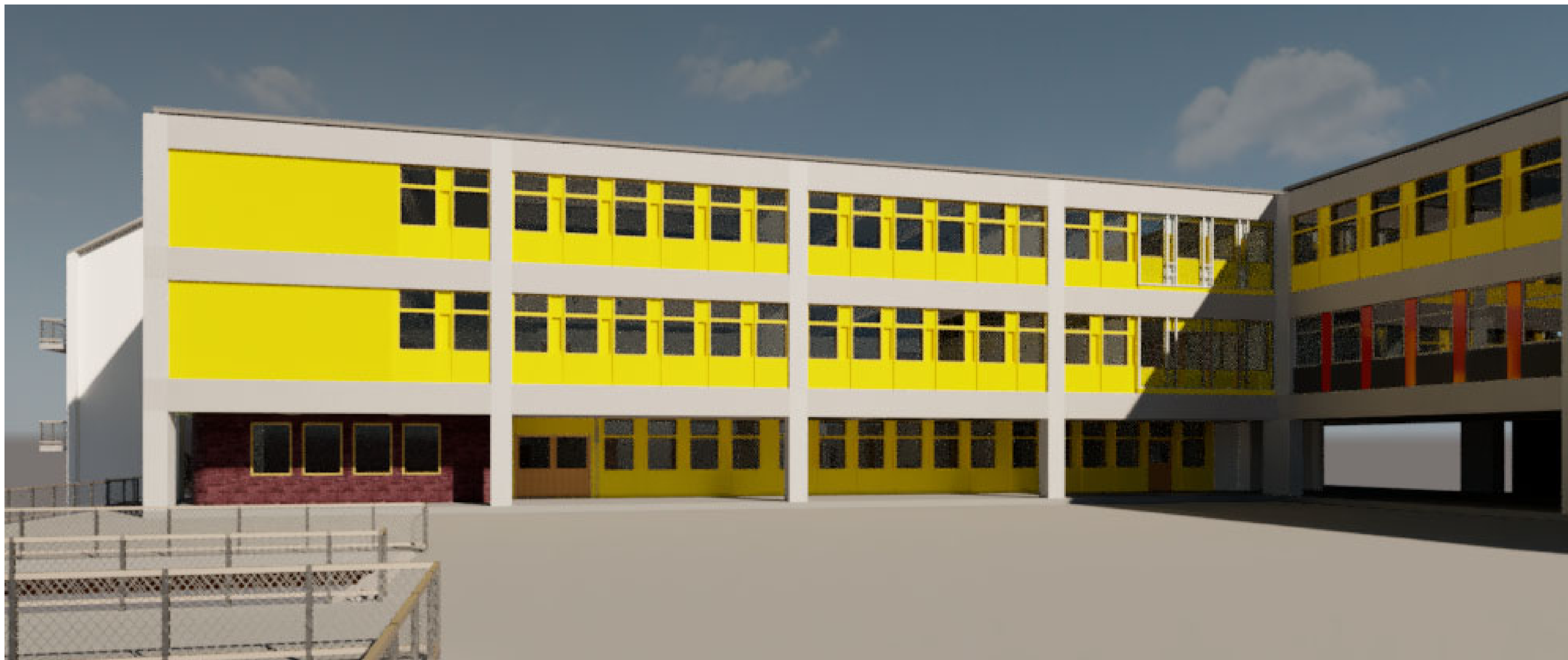
PA - VISTA GENERAL - EXISTENTE
